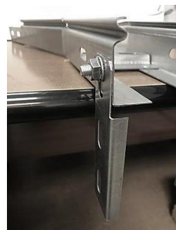
Рис. 27 Пример опуска лотка при помощи соединителя вертикального
